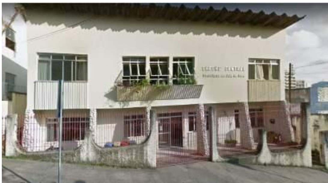
Figura 5: Fachada frontal da creche
