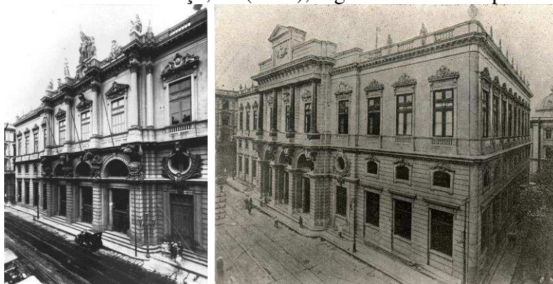
Figura 17: Fachada R. Primeiro de Março, 66 (1906); Figura 18: Fachada pós reforma (1926)
