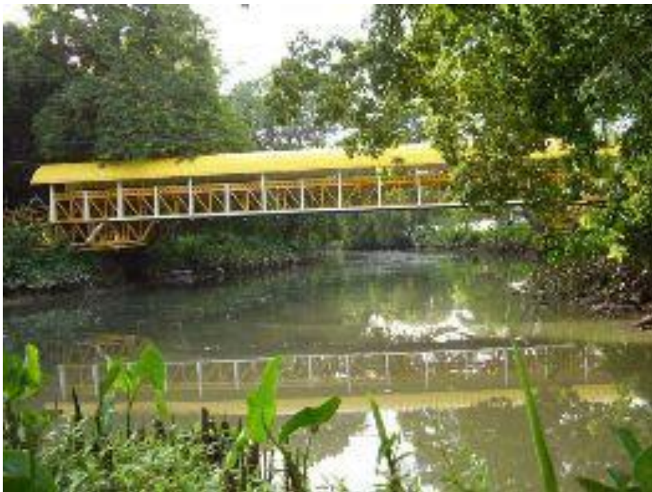
Figura 26: Ponte 19 de pedestres sobre o Igarapé do Tucunduba ligando a Área dos Centros Básicos à Área dos Centros Profissionais. Fonte: Site UFPA, out. 2014.
