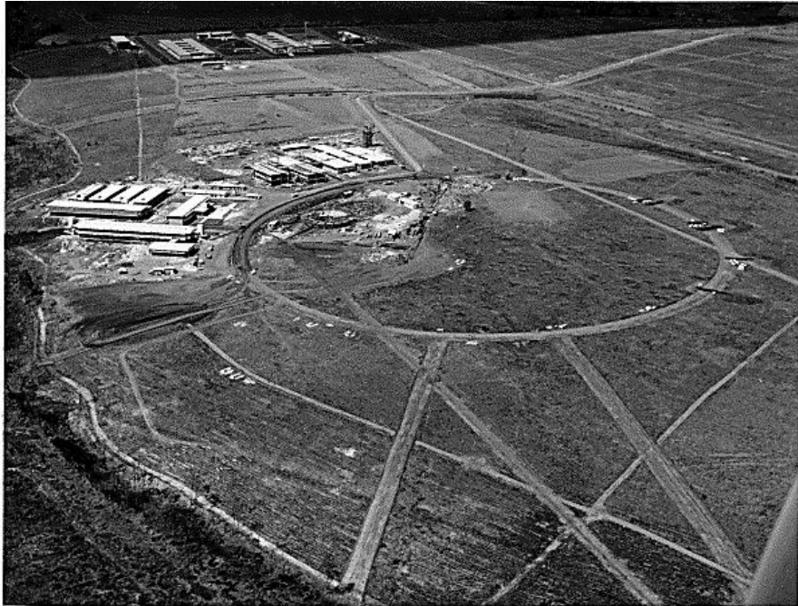
Figura 28: Imagem da construção da Unicamp, demarcando o formato radial. Fonte: Arquivo Histórico Unicamp.
