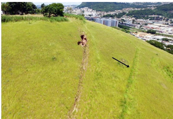
Figura 114 - Canal verde a ser revitalizado
