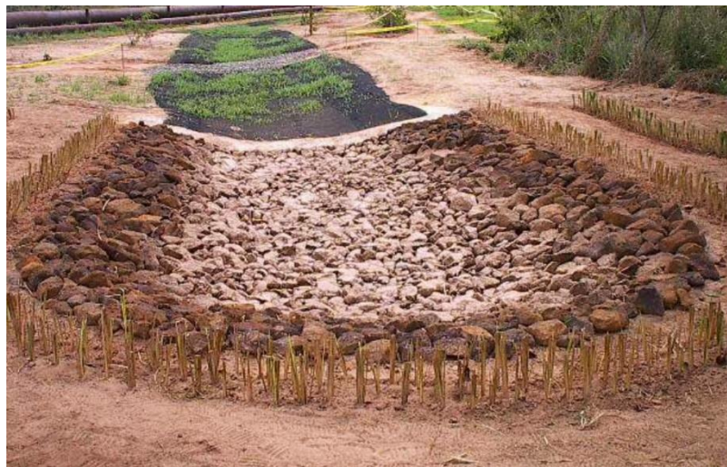
Figura 113 - Barreira de capim vetiver ao entorno do dissipador de energia
