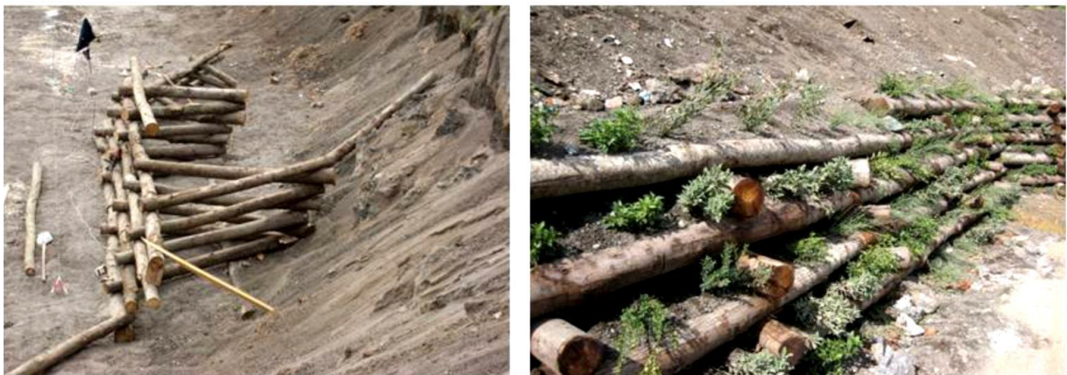
Figura 58 - Muros de suporte vivos
