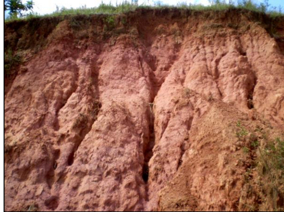
Figura 23 - Erosão em ravinas em Juiz de Fora
