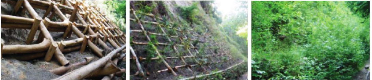
Figura 59 - Grade viva associada e estacas vivas
