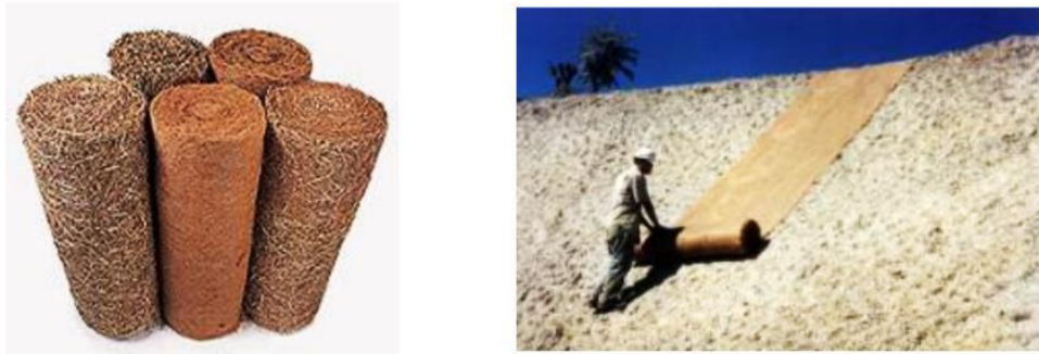
Figura 51 - Bobinas de biomantas e sua aplicação em taludes
