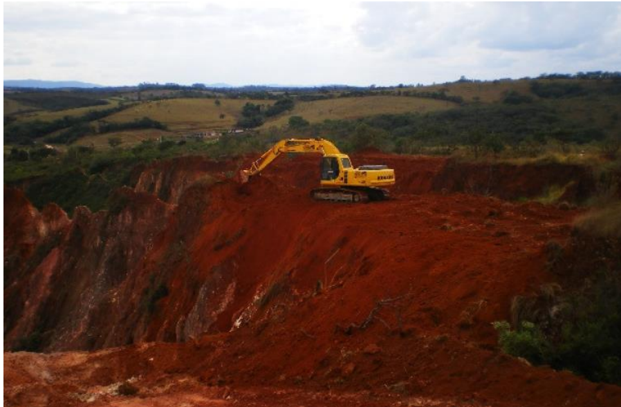
Figura 41 - Retaludamento mecânico com escavadeira hidráulica
