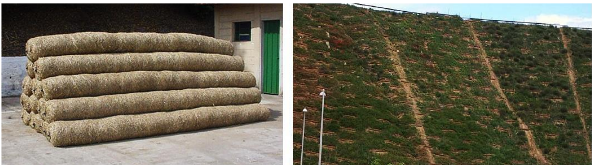
Figura 56 - Biorrolos e sua aplicação em taludes
