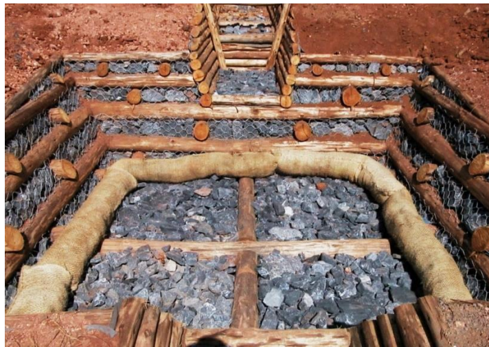
Figura 112 - Bacia de dissipação com madeira e pedras
