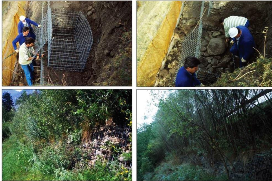
Figura 61 - Aplicação de gabiões vivos e resultado
