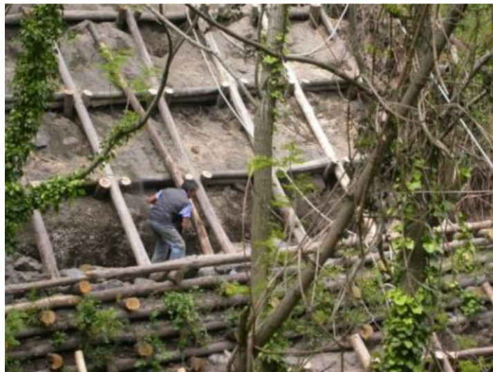
Figura 60 - Implantação de grade viva e muro vivo
