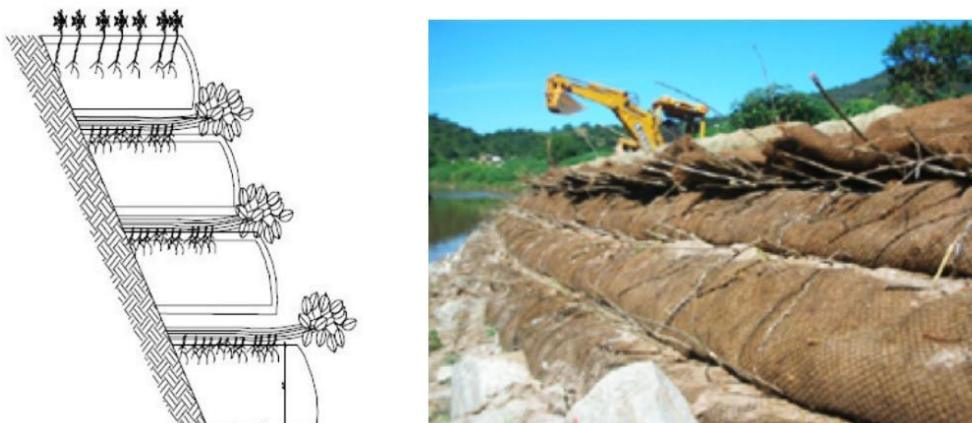
Figura 62 - Esquema e execução de solo envelopado verde
