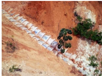
Figura 37 - Drenagem interna da voçoroca com sacos de solo cimento
