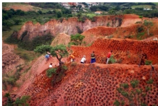
Figura 39 - Coveamento e plantio nos taludes internos da voçoroca
