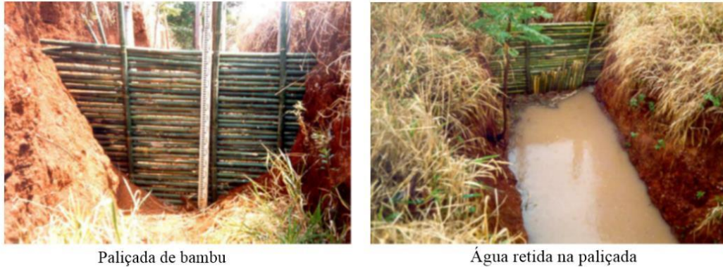
Figura 55 - Paliçada de bambu em voçoroca
