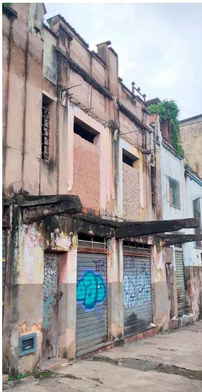
Figura 4: O estado atual do prédio da Malharia São Jorge.
