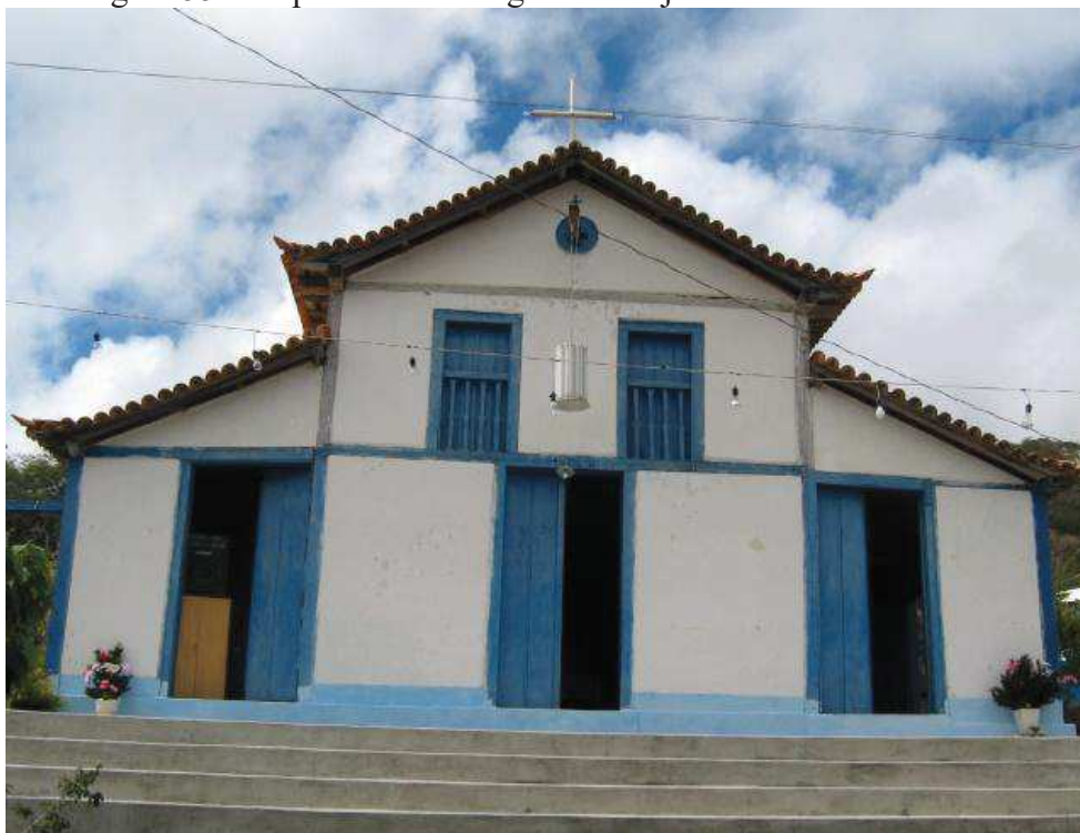
Figura 55 – Capela de São Miguel Arcanjo no Cemitério do Peixe
