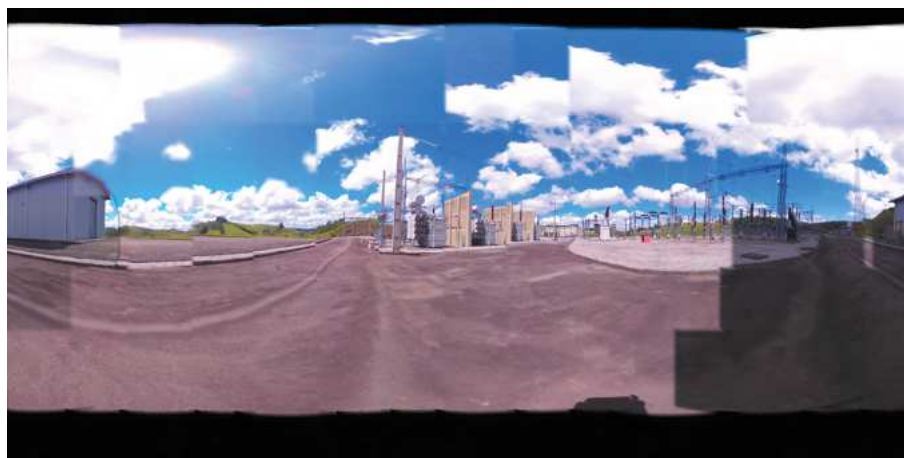
Figura 65 – Subestação de Santos Dumont com Multi-band Blending - Grey Wolf Optimizer
