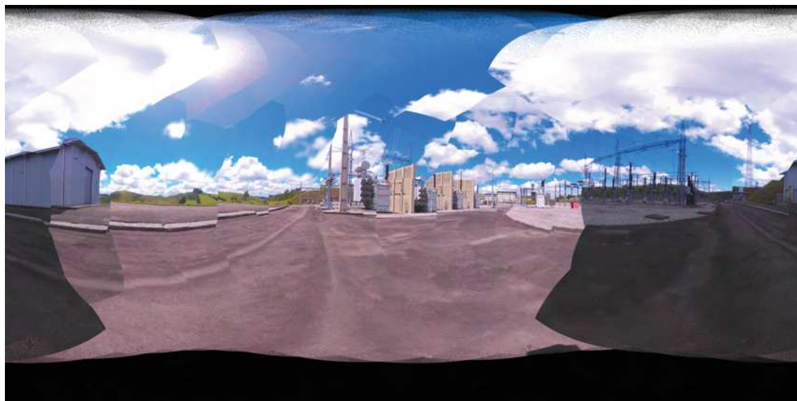
Figura 37 – Subestação de Santos Dumont
