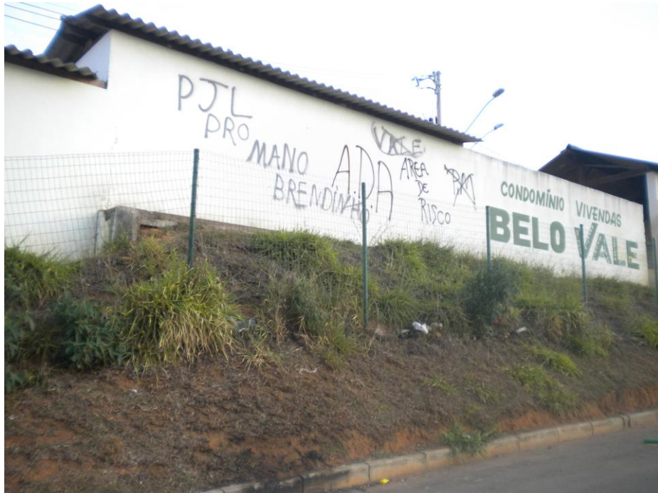
Figura 9: Imagem de parte da fachada do Condomínio Vivendas Belo Vale, empreendimento localizado no bairro São Geraldo, Juiz de Fora/MG. Fonte: arquivo pessoal, 2014.
