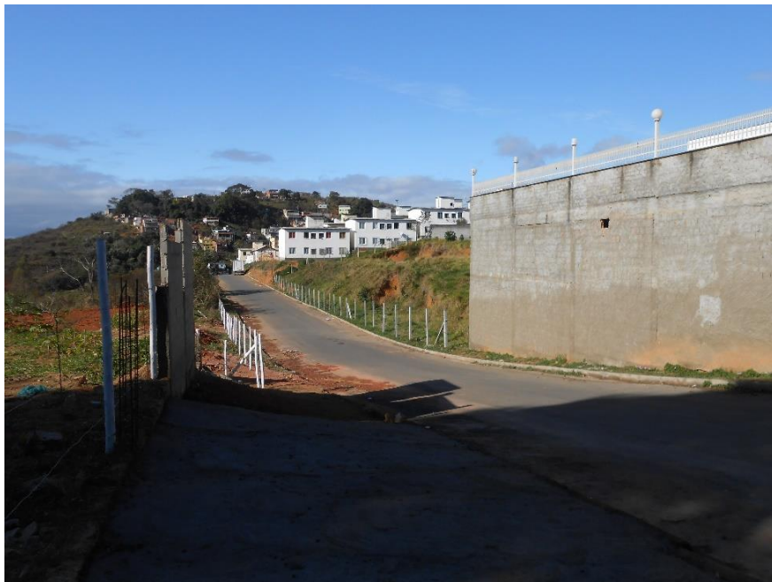
Figura 31: Trecho da rua de acesso ao condomínio sem iluminação pública (Obs.: Após o desenvolvimento do trabalho de campo este problema foi solucionado com a implantação de iluminação pública em toda a via). Fonte: ZAMBRANO, 2014a.
