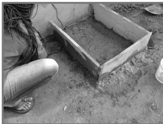
Imagem 3 - Fixação das tábuas ao solo para delimitação da composteira
