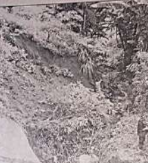
Deslizamento de terra em uma rua do bairro da Serra Verde após mais um dia de chuva
