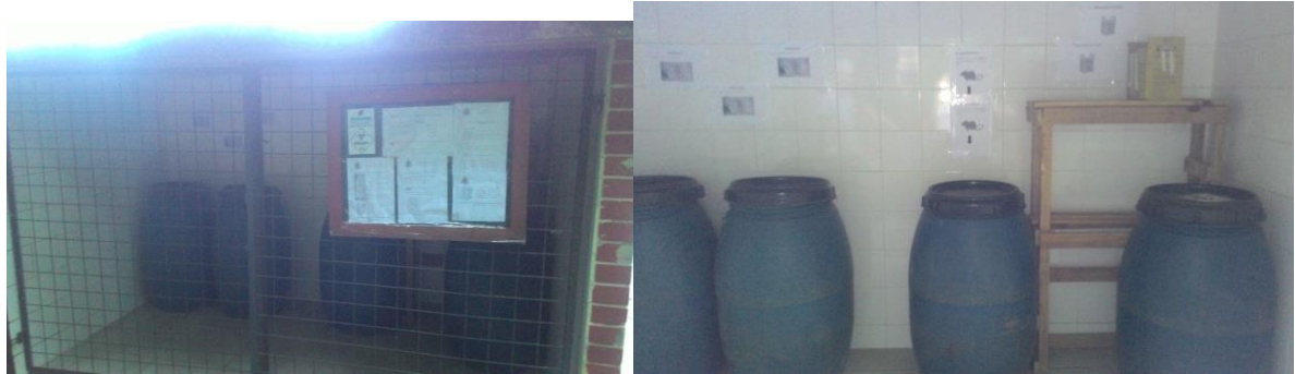
Figura 4 – Interior do abrigo de resíduos biológicos do ICB
