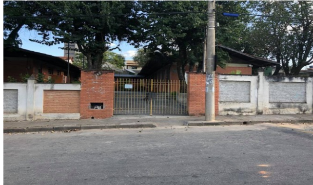
Figura 2 - Fachada principal da escola.
