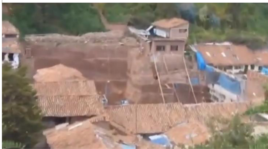
Fotografía 8 - Excavación de la construcción del hotel Saphy
