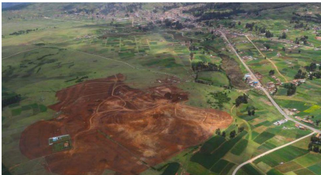
Fotografía 7 - Remoción de tierras (al 10%) del Proyecto Chinchero
