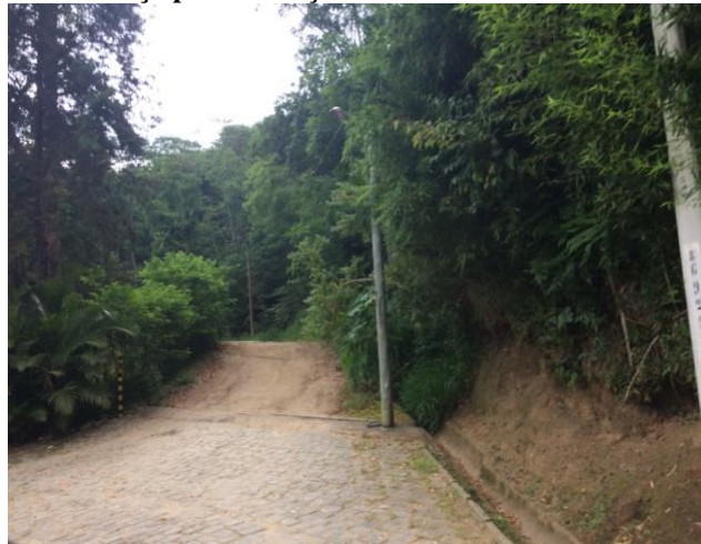
Figura 13: Diferença pavimentação: fim do condomínio e início da Tapera
