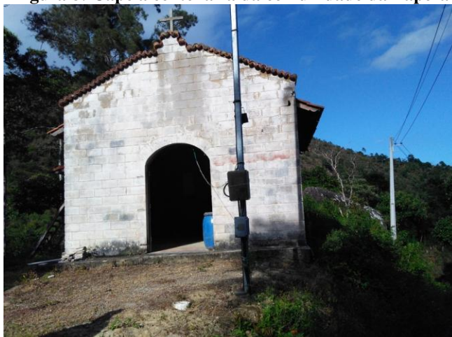
Figura 8: Capela centenária da comunidade da Tapera
