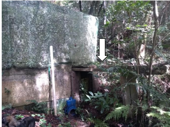
Figura 45: Ladrão do reservatório de água
