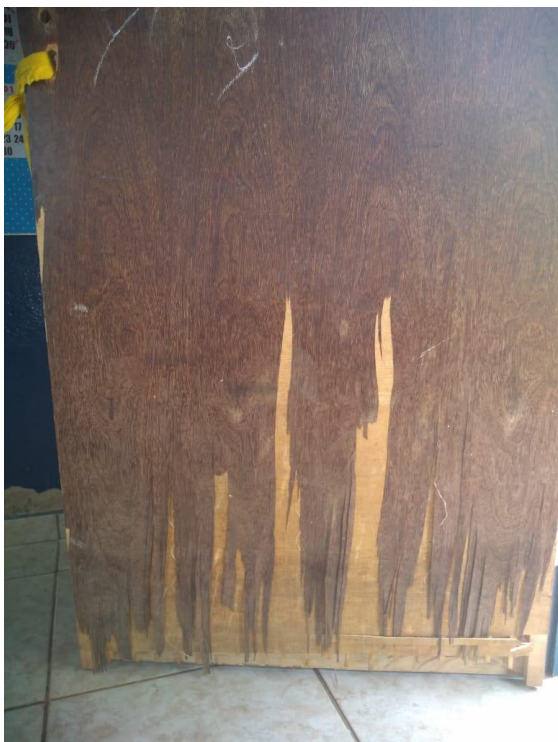
Porta de sala de aula I
