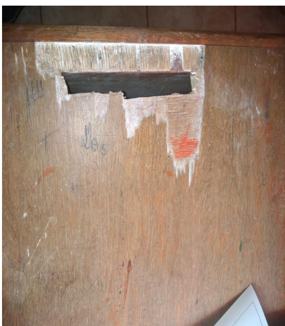
Porta de sala de aula II
