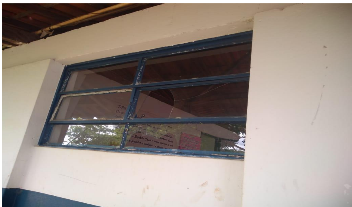
Figura 4 - Vidro danificado II
