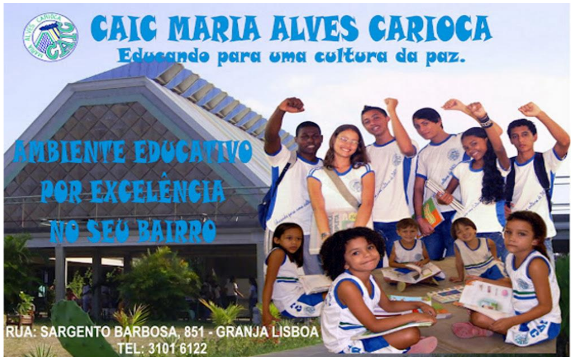
Figura 2: Fachada frontal do CAIC MAC – Banner de Divulgação Fonte: Acervo fotográfico do CAIC MAC (2010)
