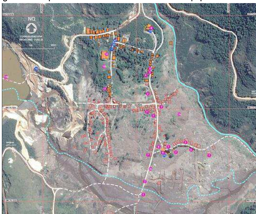
Figura 28 - Imagem aérea do distrito de Bento Rodrigues após o rompimento da barragem de Fundão. Em laranja são as edificações remanescentes, em magenta pontos de significância para a comunidade e em azul os equipamentos urbanos
