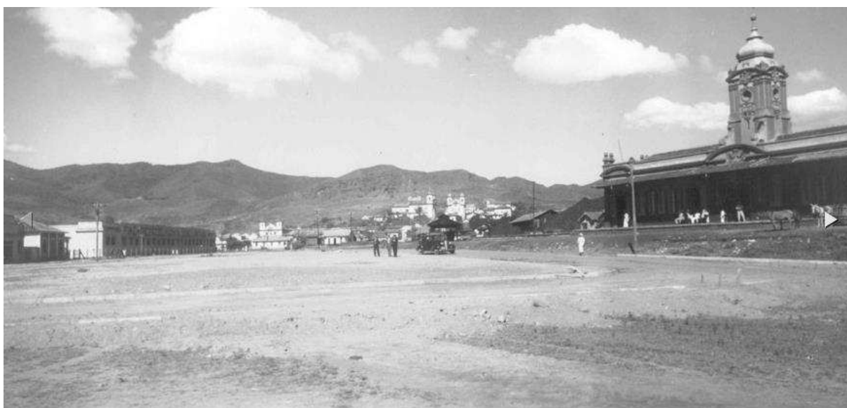
Figura 8 - Estação Ferroviária à direita e ao fundo, à esquerda a fábrica de tecidos São José
