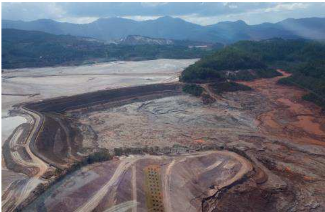
Figura 20 - Barragem de Fundão em Mariana após colapso da sua estrutura
