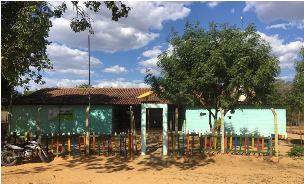
Figura 1 - Fachada da Escola Estadual Antônio Fernandes Viana
