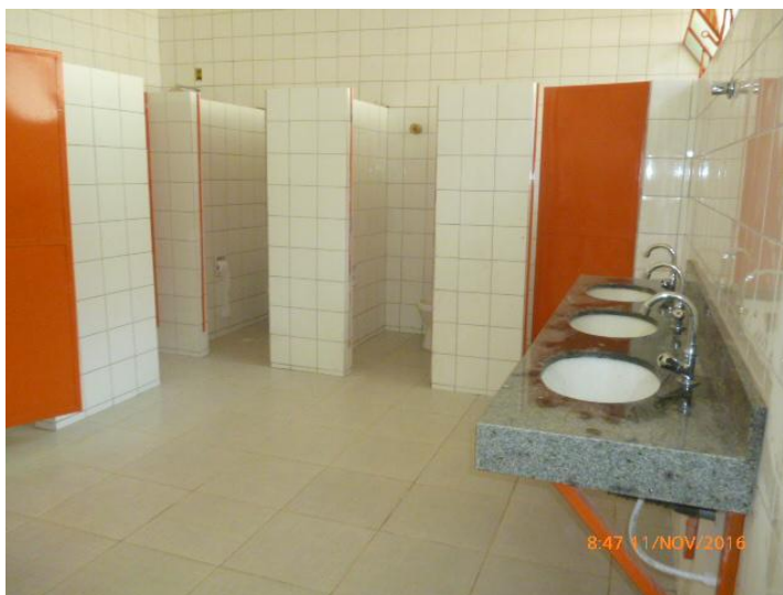
Figura 10 – Banheiro de alunos reformado da Escola Estadual A
