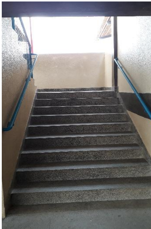
Figura 21 – Escada na Escola Estadual C
