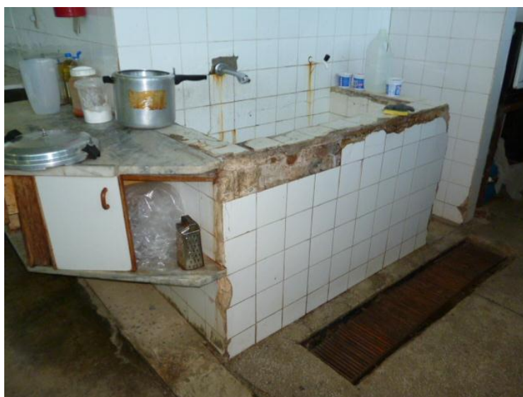
Figura 6 – Tanque de lavar panelas da Escola Estadual A
