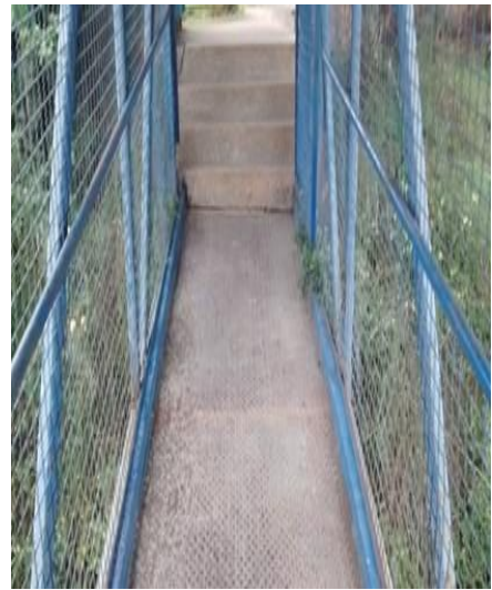
Fotografia 4 Rampa de acesso à quadra coberta e ao parquinho.
