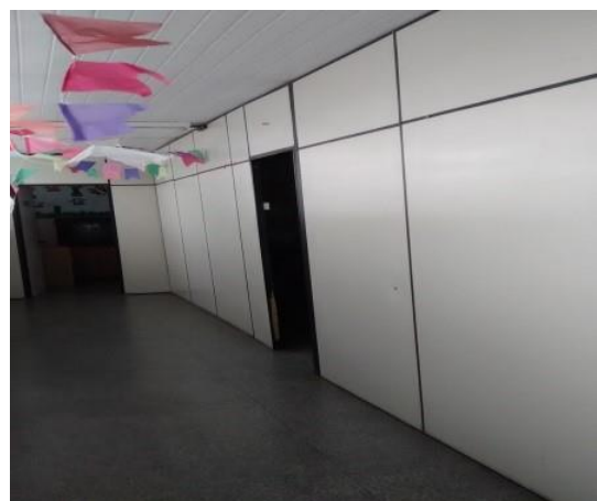
Fotografia 14 Salas do 3º andar definidas por divisórias de PVC.
