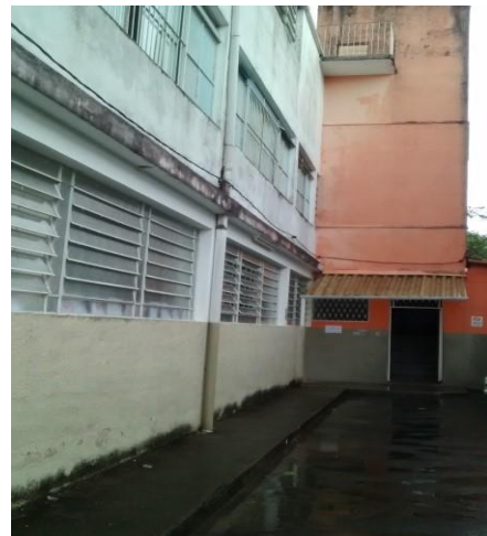
Fotografia 2 Porta de entrada da escola.
