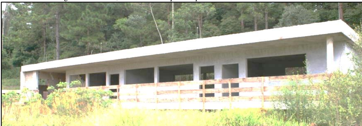
Figura 9 - LAEEP, uma das obras que compõem o contrato das "Nove Obras"
