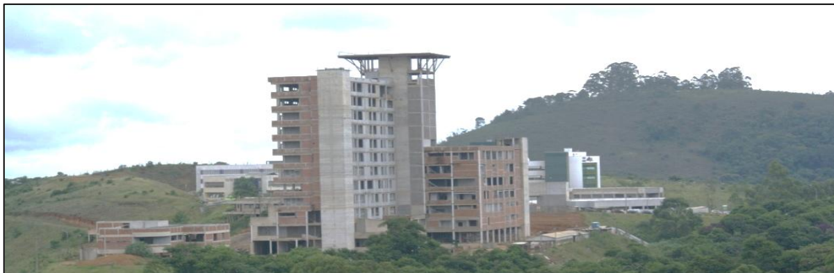
Figura 7 - Vista geral da obra de ampliação do Hospital Universitário da UFJF
