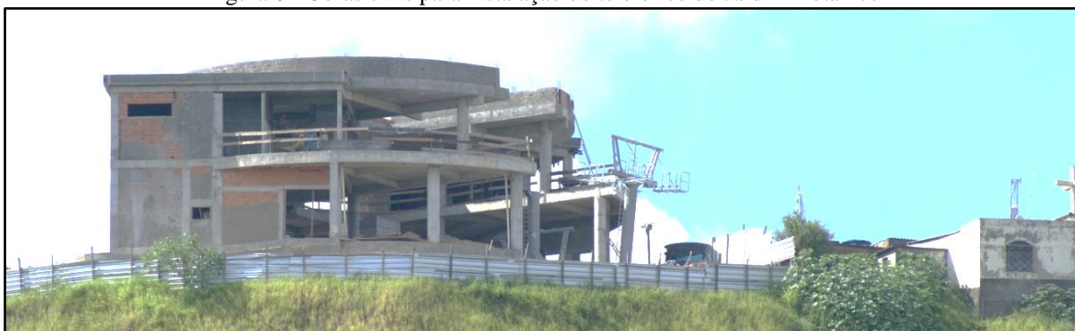
Figura 8 - Obras civis para instalação do teleférico do Jardim Botânico
