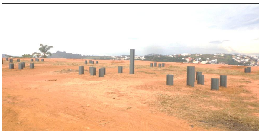
Figura 11 - Vista geral da obra da Nova Reitoria, paralisada desde 2015
