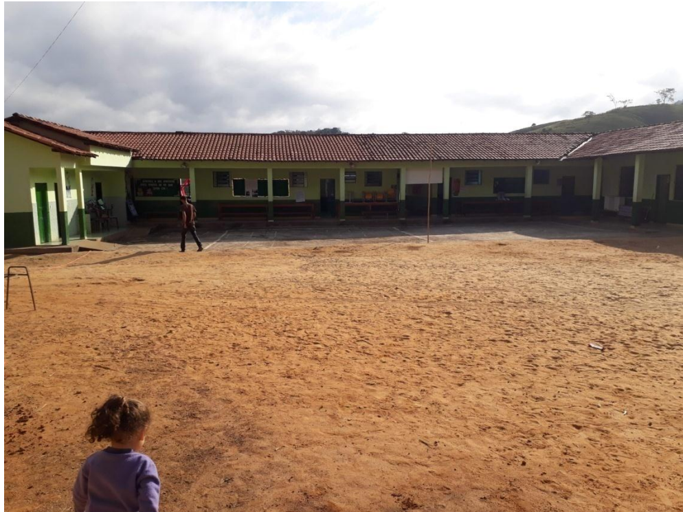
Figura 6 – Área interna da Escola Estadual Olegário Maciel
