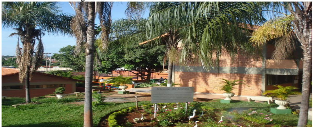
Figura 4 - Foto da entrada lateral da Escola JK
