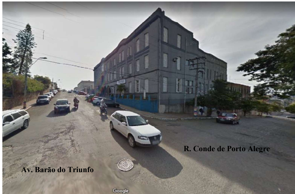
Figura 13 - Campus Sant'Ana do Livramento da Universidade Federal do Pampa – UNIPAMPA
