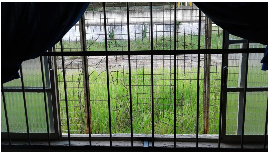
Figura 11- Janela da Sala dos Professores. A sala está protegida com 2 grades, uma delas com sinais de arrombamento.
