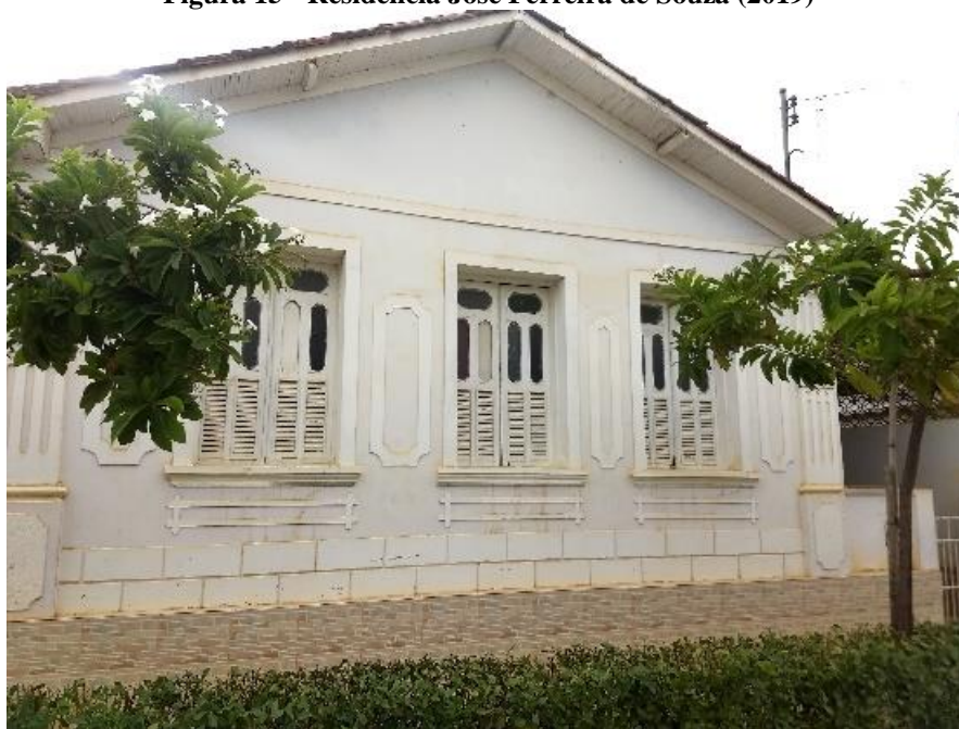
Figura 15 - Residência José Ferreira de Souza (2019)
