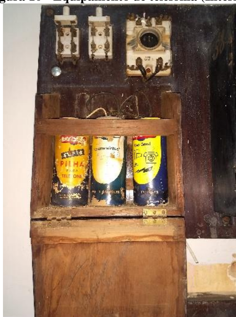
Figura 10 - Equipamento de telefonia (Interior)
