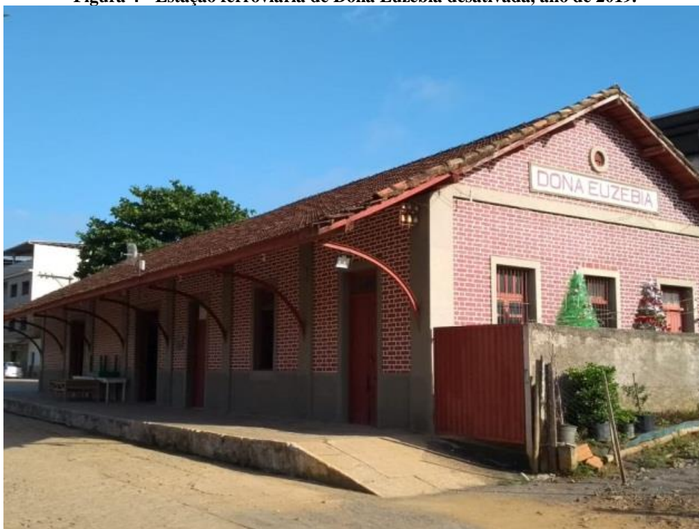
Figura 4 - Estação ferroviária de Dona Euzébia desativada, ano de 2019.
