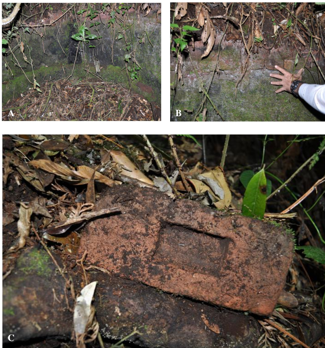
Figura 2 - Resquícios de estruturas de fornos abandonados na microbacia hidrográfica (MB3) Onde: a) Forno de carvão abandonado onde se vê escavado o suspiro do forno (centro da imagem) com uma cinta de alvenaria na base. B) Linha de tijolos (indicada pela mão) na parte superior do forno que servia de suporte para a cobertura dos mesmos. C) Tijolo remanescente no interior do forno.
