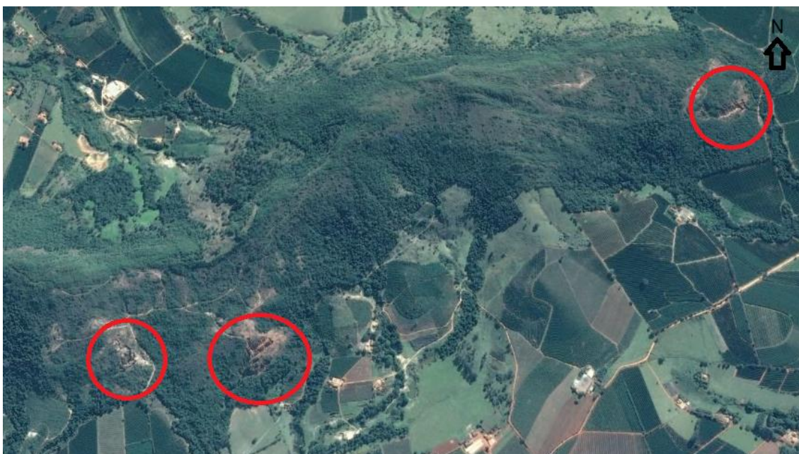
Figura 30: Ocorrências de voçorocas na serra da Fortaleza. Fonte: Google Earth (2017).
