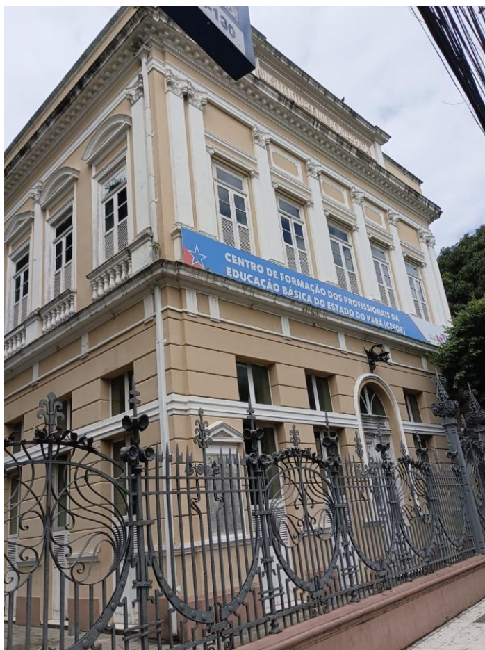
Figura 1 - Prédio do CEFOR, no centro de Belém.
