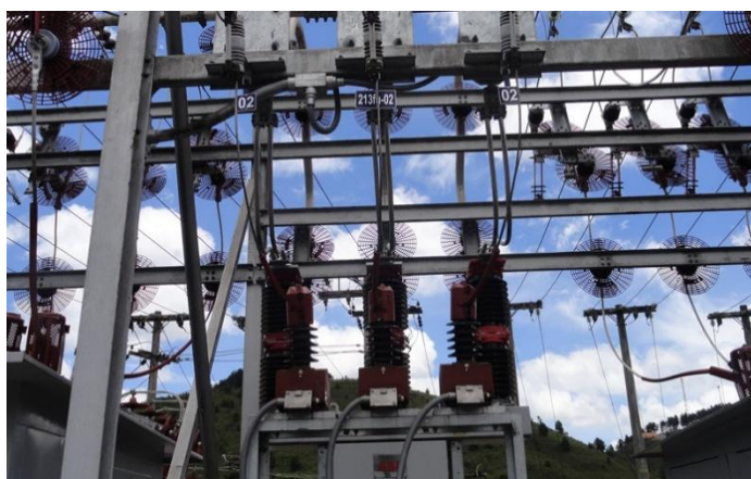
Figura 6 - Disjuntor de média tensão (ENGENHARIA, RTT, 2018).
