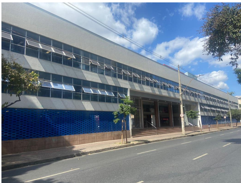
Imagem 12 – Vista externa do Prédio Anexo
