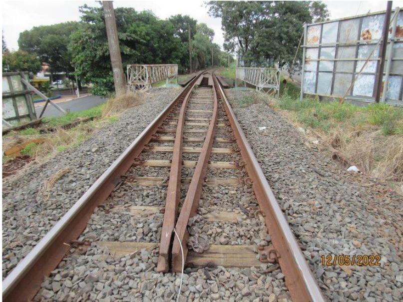
Figura 9 – Ilustração da adoção de trilho duplo nas zonas de transição - Viaduto em Nova Odessa SP, Km 74+381. Fonte: Projeto de pesquisa: Desenvolvimento de estratégias de SHM para ferrovias [2]
