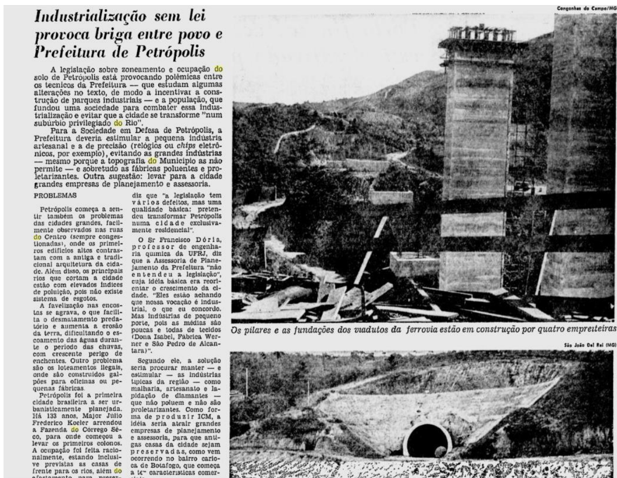
Figura 07 – Construção de viadutos e túneis em Congonhas, 1978
