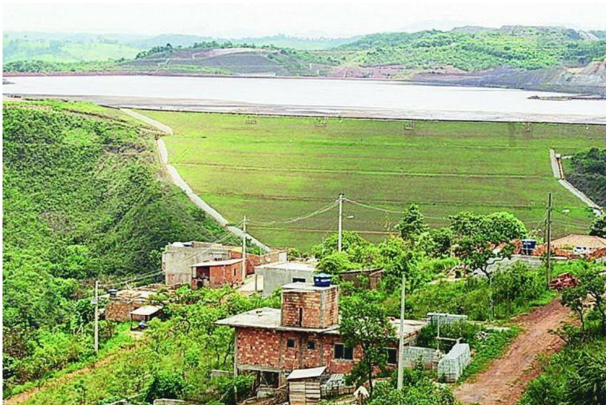
Figura 11 – Barragem de rejeitos da CSN na Mina Casa de Pedra
