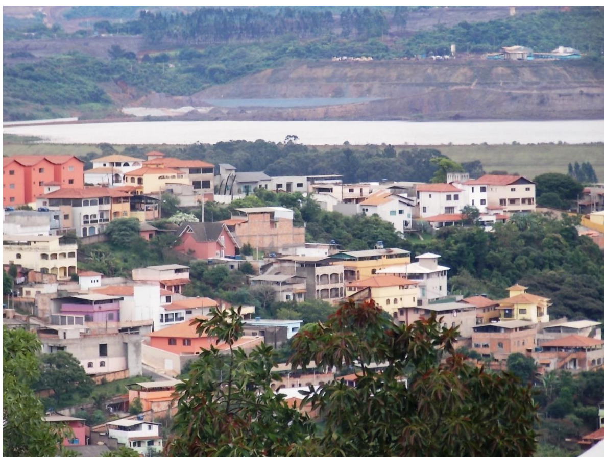
Figura 63 – Barragem da CSN, em Congonhas (MG) próxima às residências dos moradores
