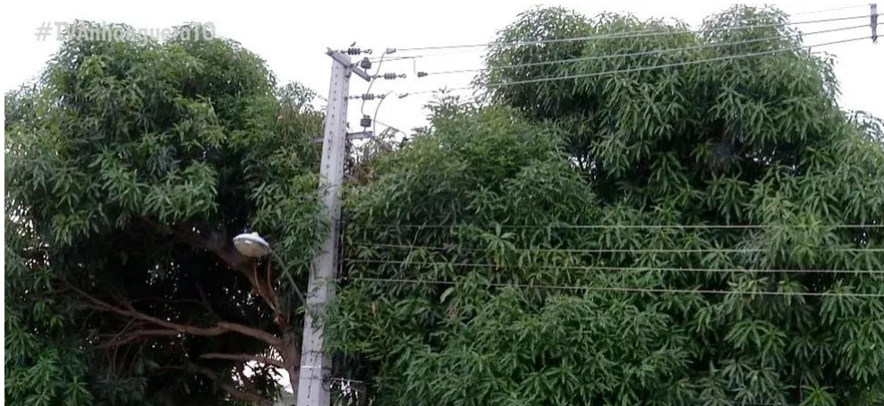
Figura 3 – Galhos de árvore encostados na rede elétrica em Palmas
