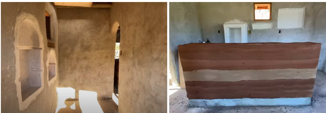
Figura 23: a) Paredes internas em COB com nichos em tadelakt; b) Balcão central em taipa de pilão.
