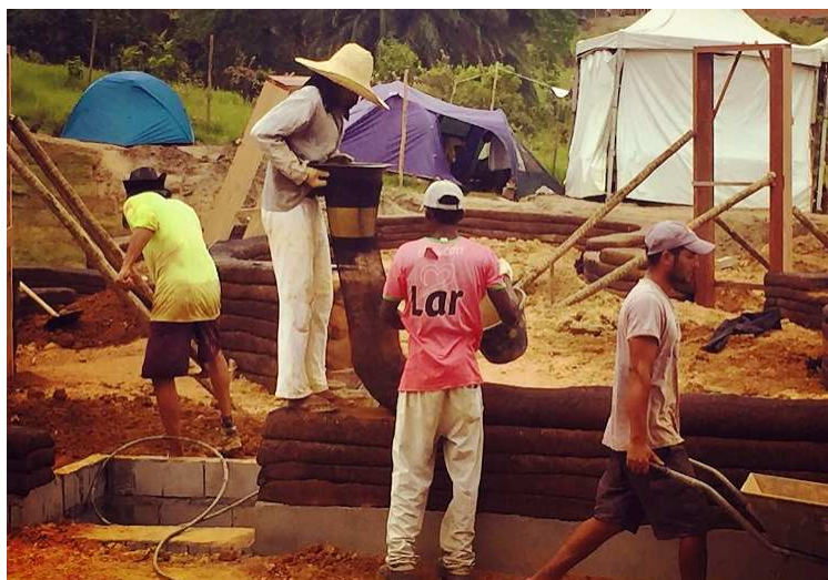
Figura 9: Trabalhadores em obra construindo com hiperadobe
