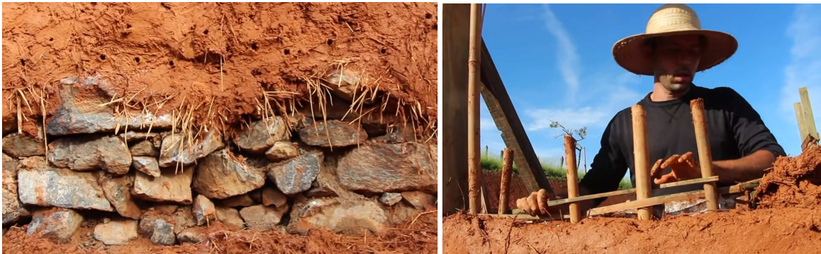
Figura 20: a) Fundação aparente; b) Estrutura interna à parede.
