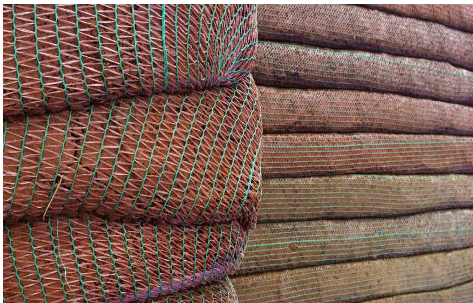
Figura 7: Sacos de raschel preenchidos por terra compondo uma parede de hiperadobe
