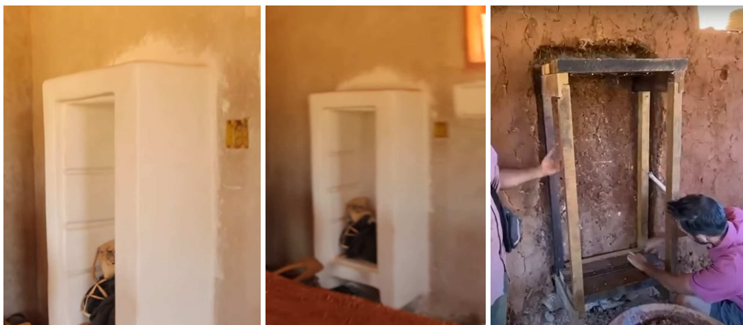
Figura 22: Processo de construção da refresqueira
