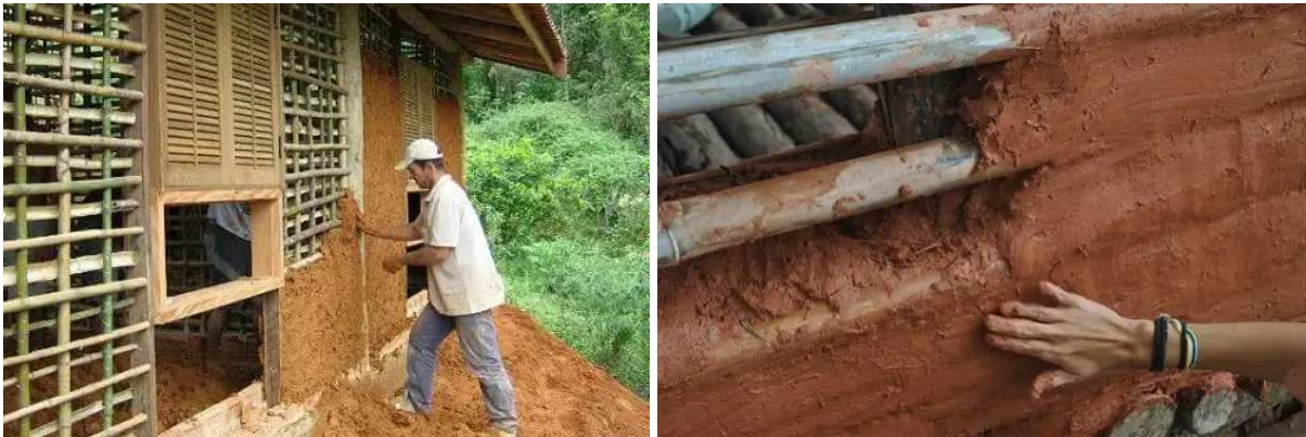
Figura 2: Registros do processo de construção da taipa de mão
