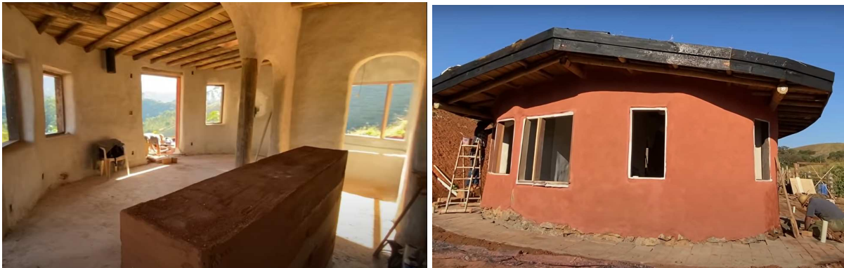
Figura 19: a) registro interno construção em COB; b) registro externo construção em COB.
