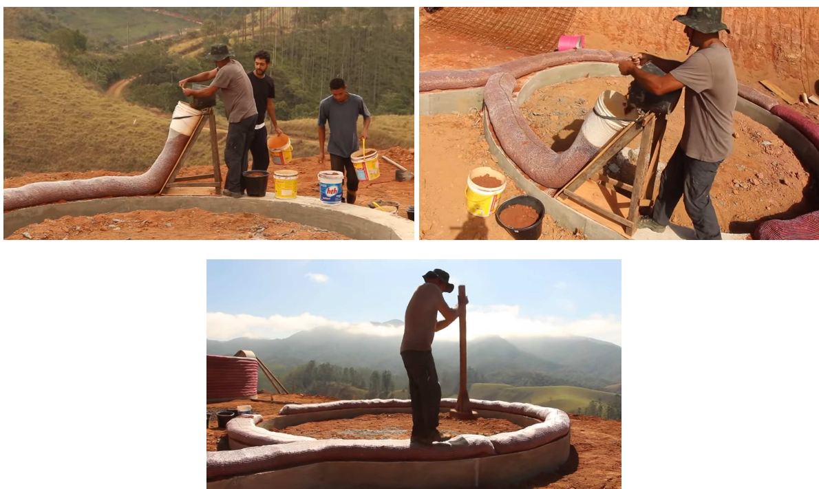
Figura 12: Trabalhadores em obra construindo em hiperadobe
