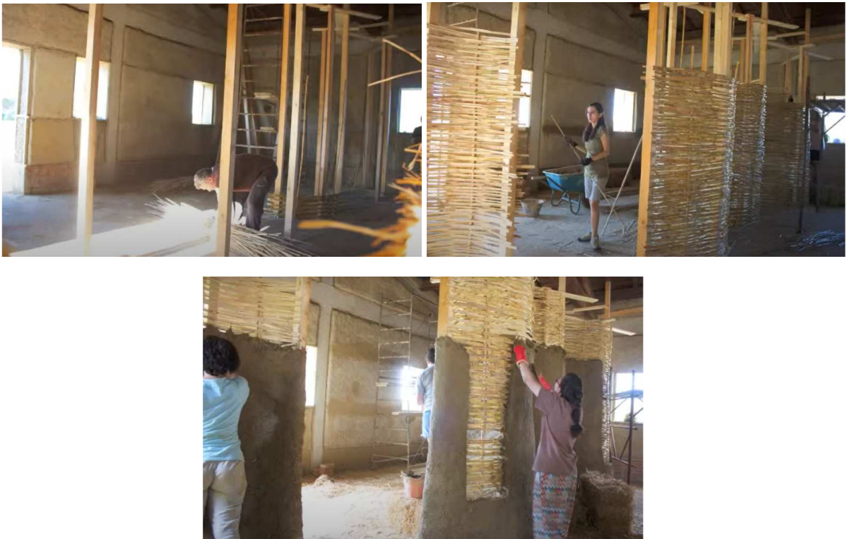
Figura 6: Etapas de construção da parede
