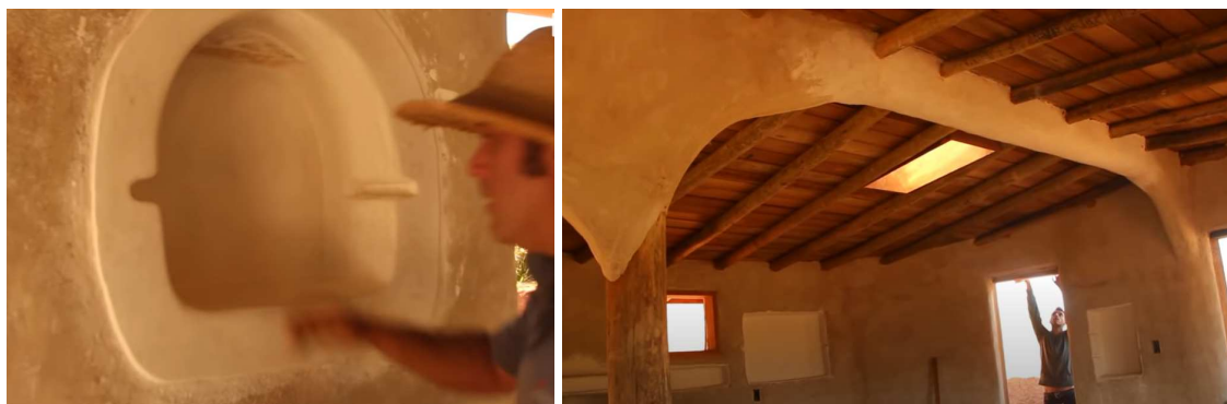
Figura 21: a) Oratório em tadelakt; b) Arco em COB sobre estrutura do telhado
