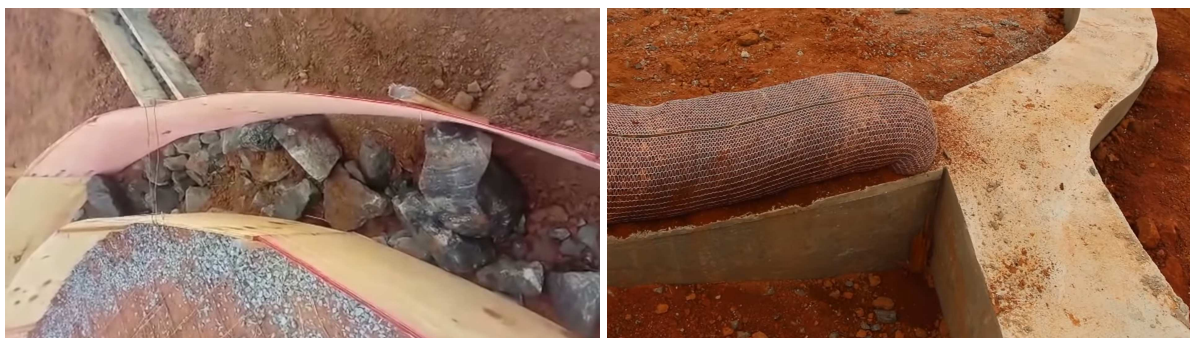
Figura 10: Processo de construção da fundação
