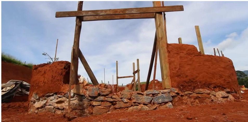
Figura 16: Estruturas aparentes durante o processo de construção
