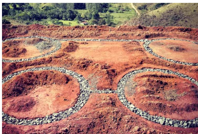
Figura 11: Processo de construção da fundação
