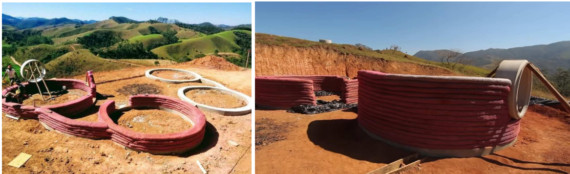
Figura 14: Evolução de fiadas na construção com hiperadobe
