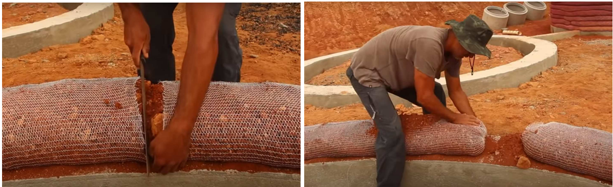
Figura 13: Trabalhador fazendo corte em fiada de hiperadobe
