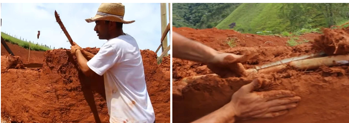
Figura 18: Massa de COB sendo aplicada em estrutura de bambu
