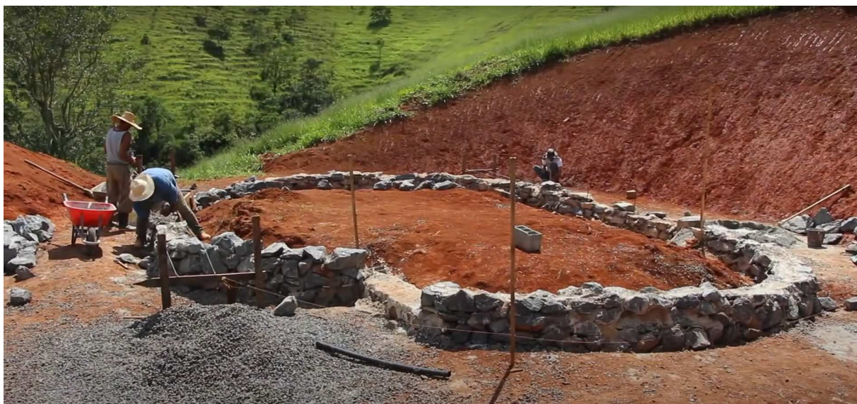
Figura 25: Processo de construção de uma fundação de pedra
