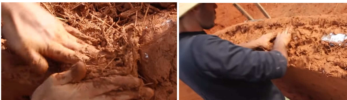
Figura 15: Massa COB sendo adicionada à parede e modelada
