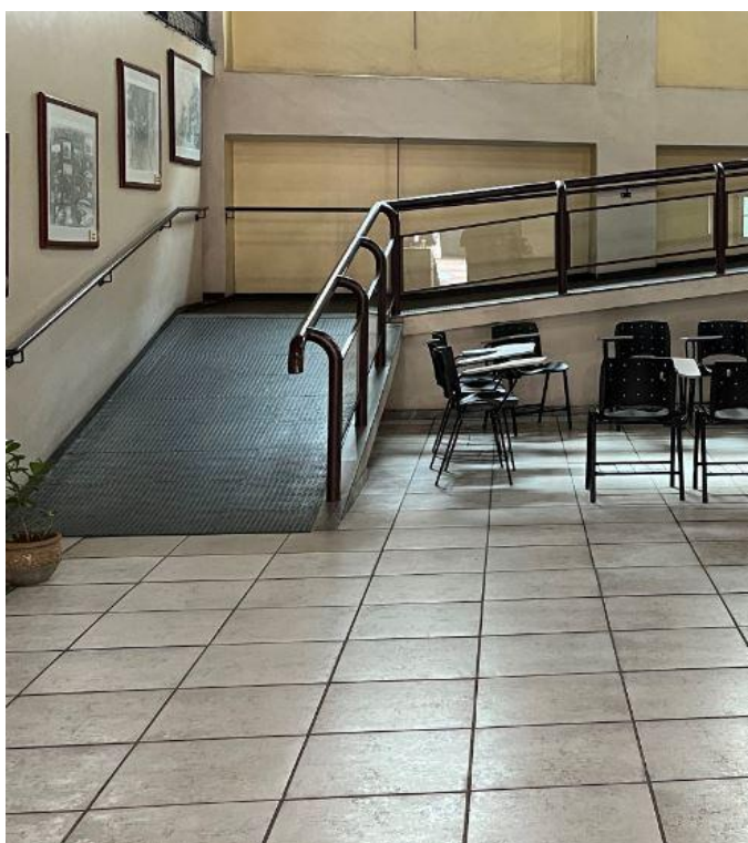
Figura 19 - Entrada do CCI e rampa para o 2º pavimento.
