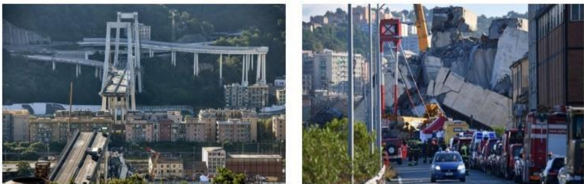
Figura 1 – O colapso da Ponte Morandi Itália
