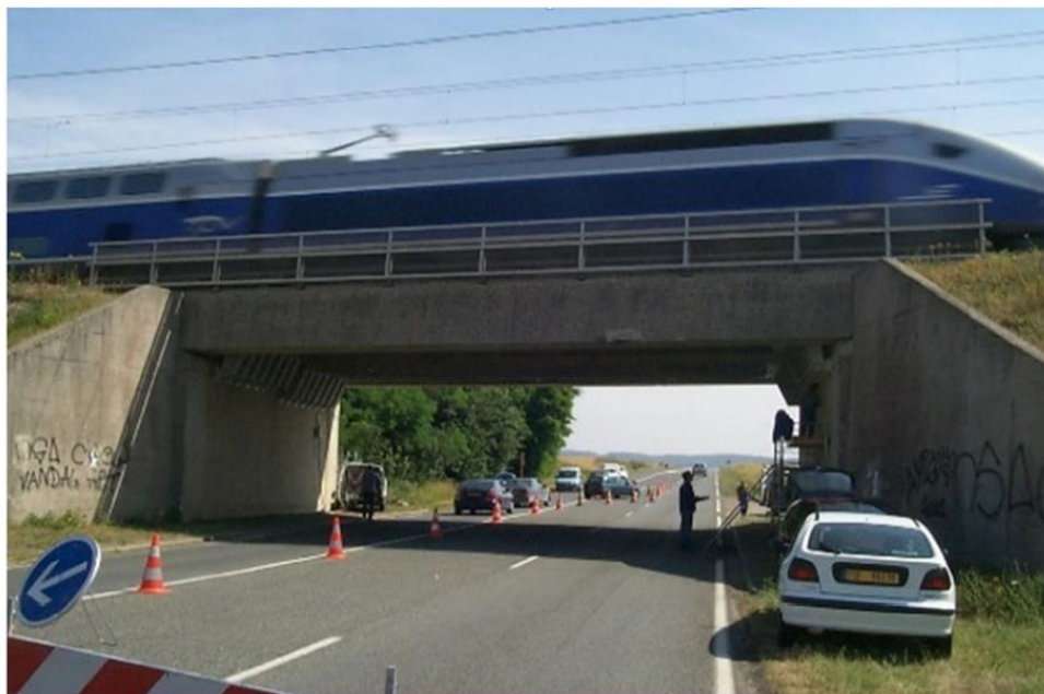
Figura 21- Vista geral do Viaduto PK 075+317
