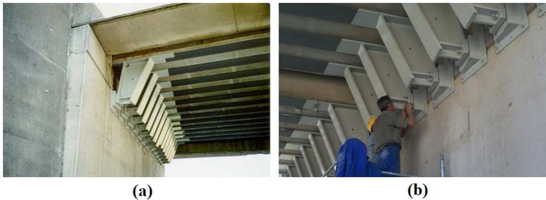
Figura 22 - Detalhes do procedimento de reforço e aperto dos mancais
